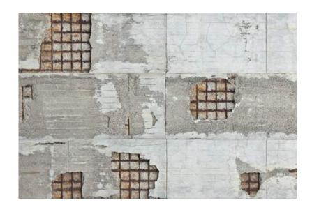
混凝土保护层、均质性和混凝土强度是确定您的结构是否有发生混凝土癌 (腐蚀、开裂、剥落、失效……) 风险的关键参数。
